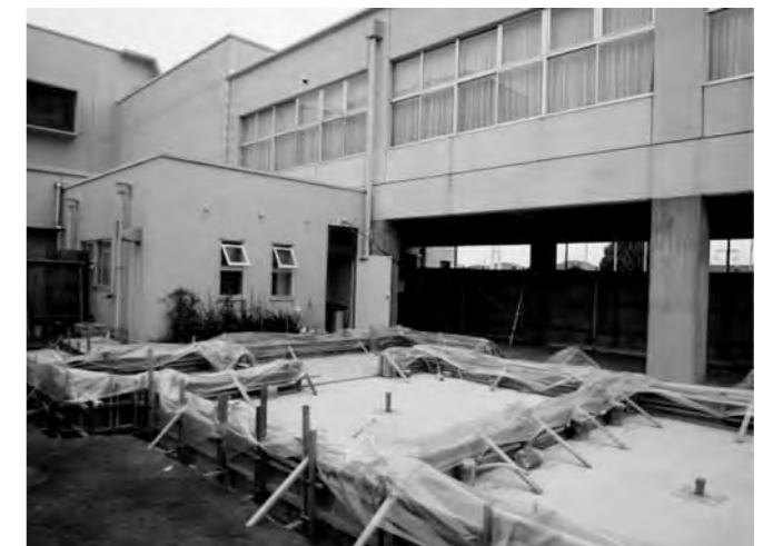
▲ 屋外に併設されるトイレの設置工事
