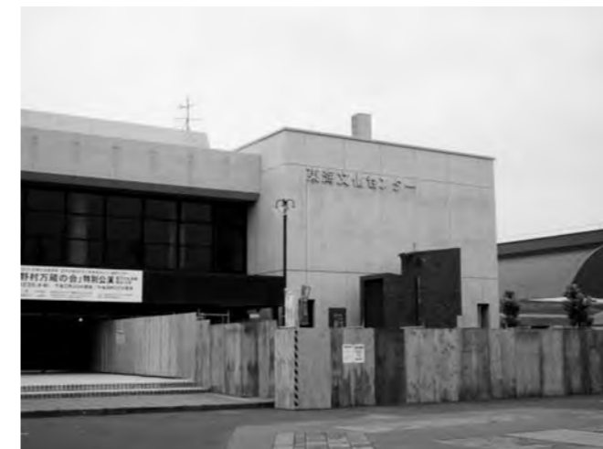
▲ 玄関脇のスロープの設置工事
