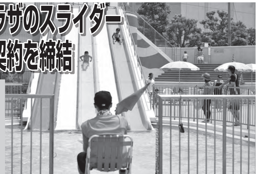
▲今シーズン限りで改修されるスライダー
