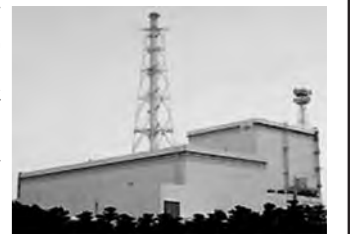
(日本原電ホームページより)
