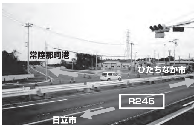
▲開通間近の常陸那珂港山方線と国道245号との交差点付近
