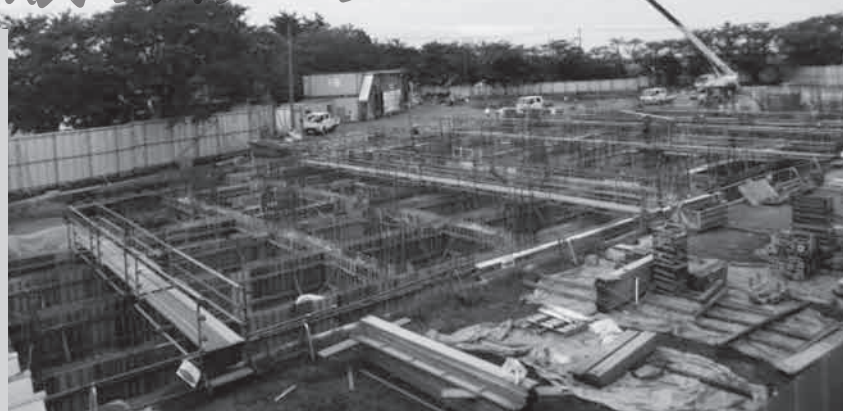
▲平成25年7月から始まった東海中学校の建設工事
