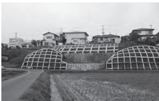
▲南台団地の法面の耐震化工事が終了
