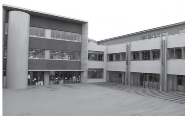
▲中丸小学校の校舎建設工事が終了
