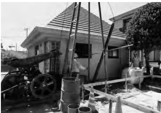
▲井戸の掘削作業の様子(村松コミセン)
